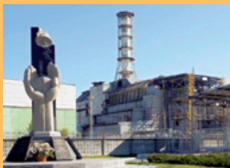
Der 1986 explodierte und mit einem Beton-sarkophag umhüllte Reaktorblock 4 in Tschernobyl. Die Westwand muss bereits mit einem Stahlgerüst abgestützt werden.
