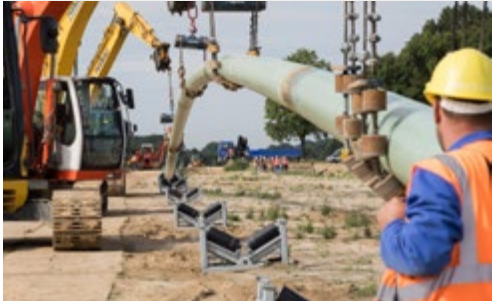
Oben: Die Rohre wurden im Mannesmann Line Pipe Werk in Siegen gefertigt und im grau-roten Design umhüllt.
