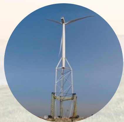
... hebt das SES (Self-Erection-System) die hunderte Tonnen schwere Konstruktion in die Luft, bis die Zielhöhe erreicht ist.
