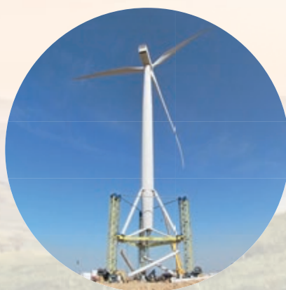
Nachdem das Maschinenhaus, der Turmdrehkranz und der Rotor mit dem Turm verbunden wurden, ...
