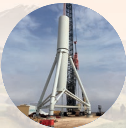
Aufbau mit dem Nabralift-System: Zunächst wird die Turmspitze mit dem dreiarmigen Turmübergang verbunden.
