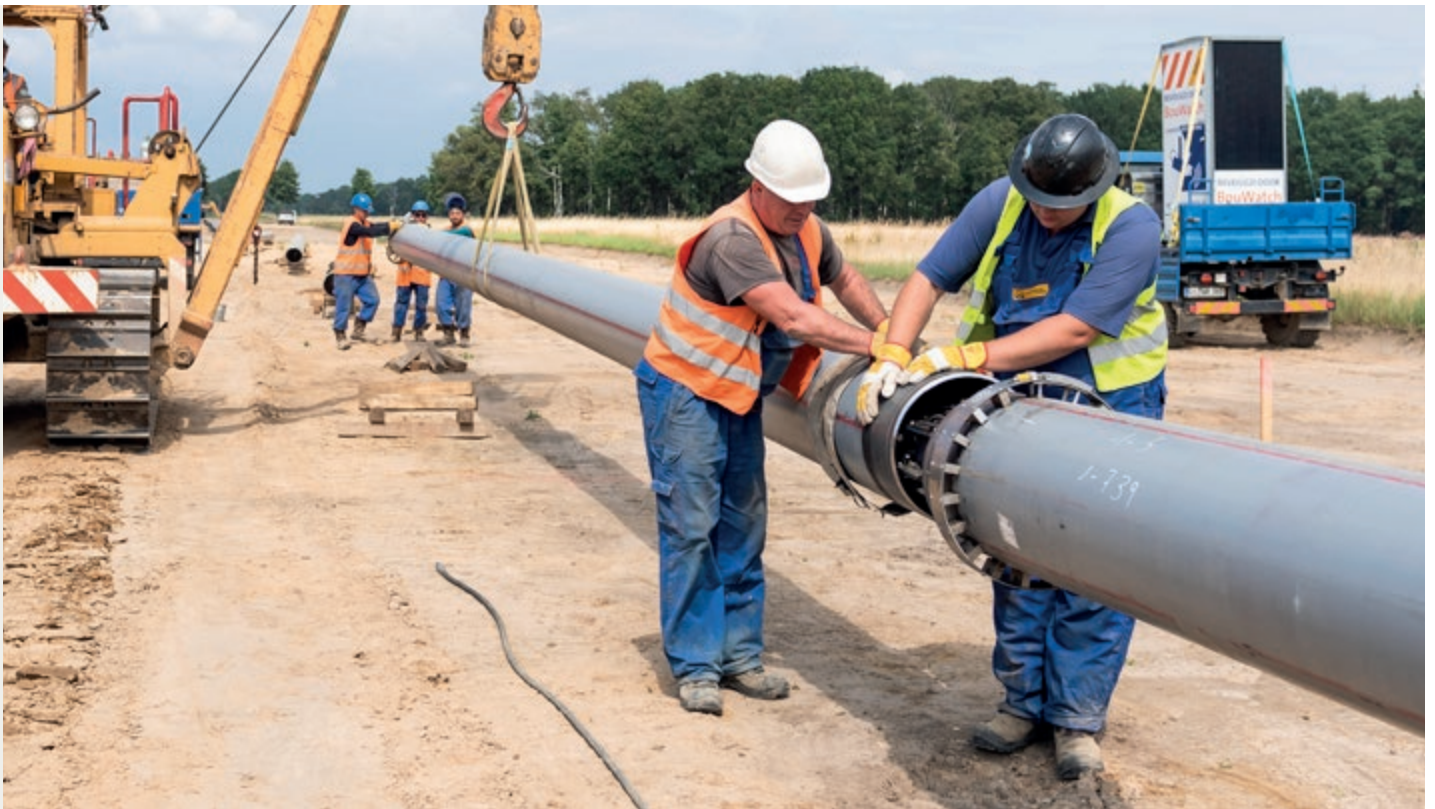
Links: Blick auf das Volkswagen-Werksgelände in Wolfsburg. Oben: Vorbereitungen zur Verlegung der neuen Gashochdruckleitung von Walle nach Wolfsburg.
