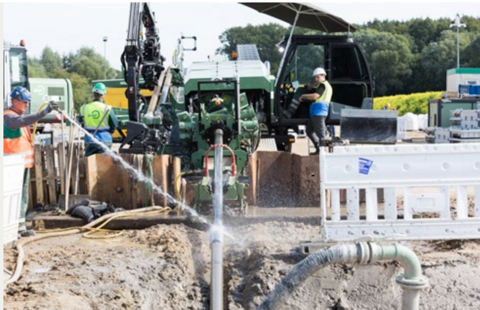
Unten links und oben: An insgesamt 14 Stellen wurden die bis zu 1,9 km langen Rohrstränge im HDD-Verlegeverfahren grabenlos und besonders umweltverträglich verbaut.
